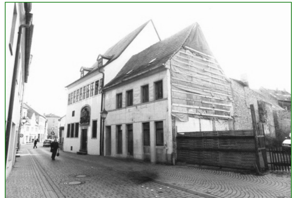
Das Haus Lutherstraße 17 im Jahr 2002 vor dem Abbruch. Nach Auskunft der Lutherstiftung wurde das Haus von einer jüdischen Nachfahrin erworben.
