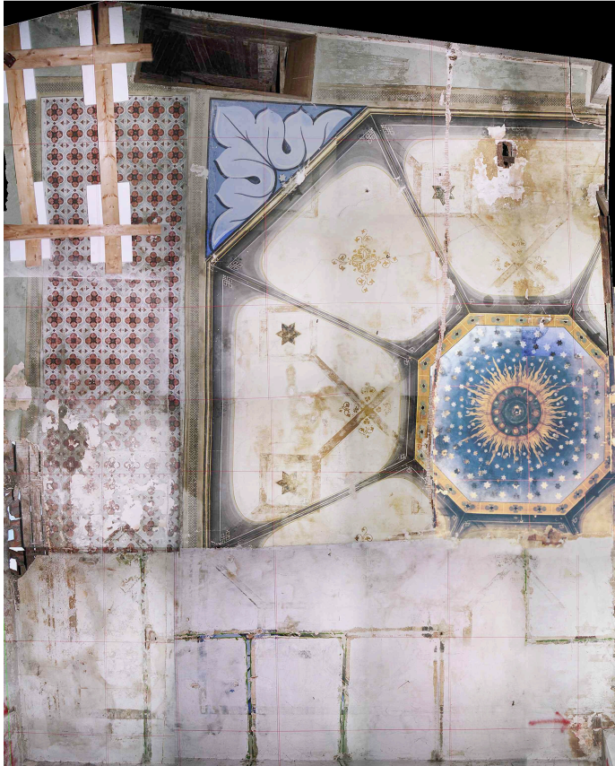
Gesamtansicht der Saaldecke
